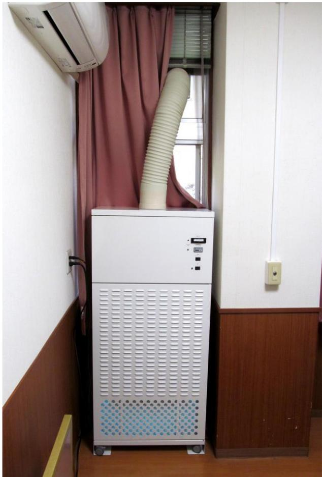
強力な陰圧で大容量の室内空気を収集して、空中の浮遊物を「ヘパフィルター」で吸着します。吸着した菌を「紫外線照射」で殺菌し、感染リスクを抑え安全な空気と入れ替える装置です。
